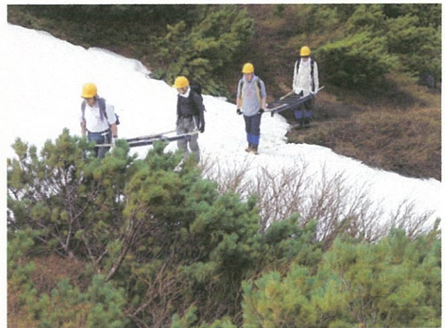
資材を人力で現場へ搬送
