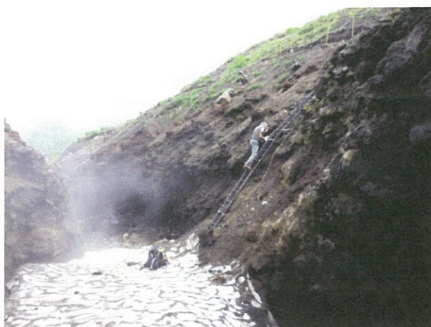
鉄製ハシゴ(2.5m×4基)連結作業
