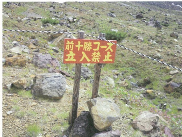
十勝岳線規制看板塗装補修
