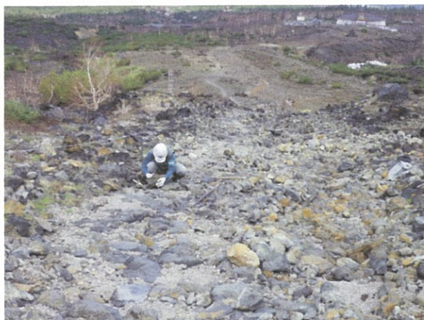
十勝岳線望岳台園地上部歩道補修施工中
