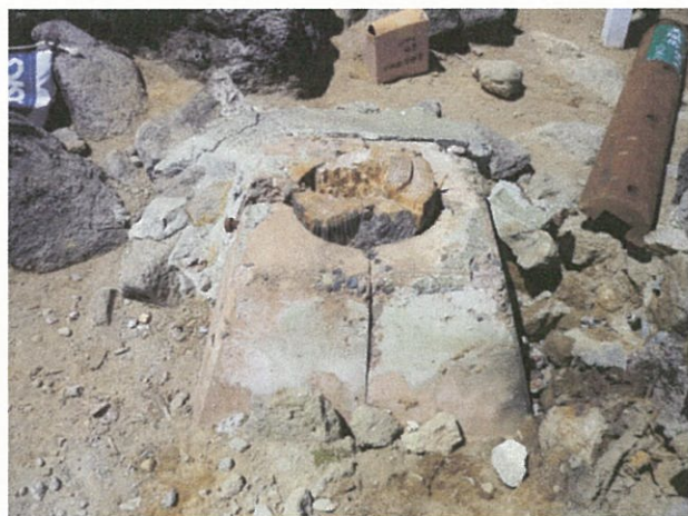
旧標識台座部分撤収前
