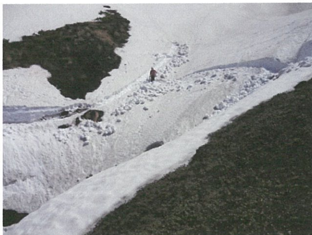
鉄製ハシゴ設置箇所除雪(6月初旬)
