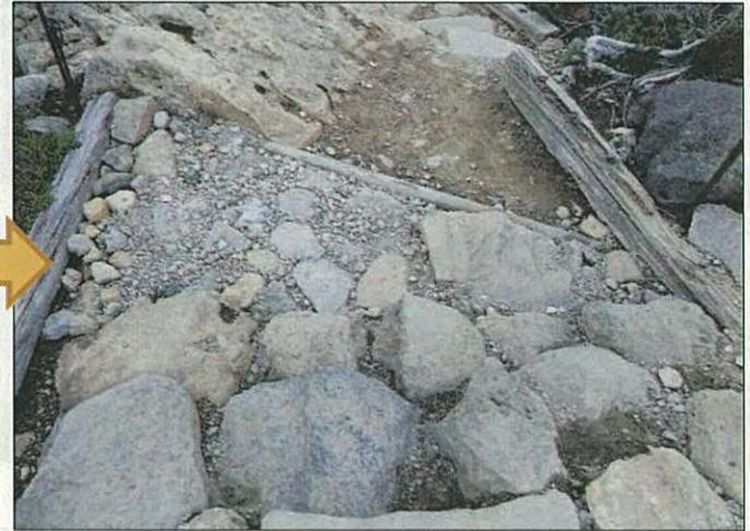
上部で歩行を妨げていた石を下方に移動し段差として配置した。
