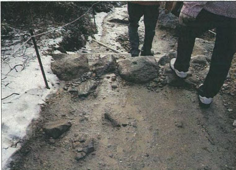
・組み換えの利点は、石材が大きく平滑な面もあるので、正しく施工できると恒久的に使える段差になること。
