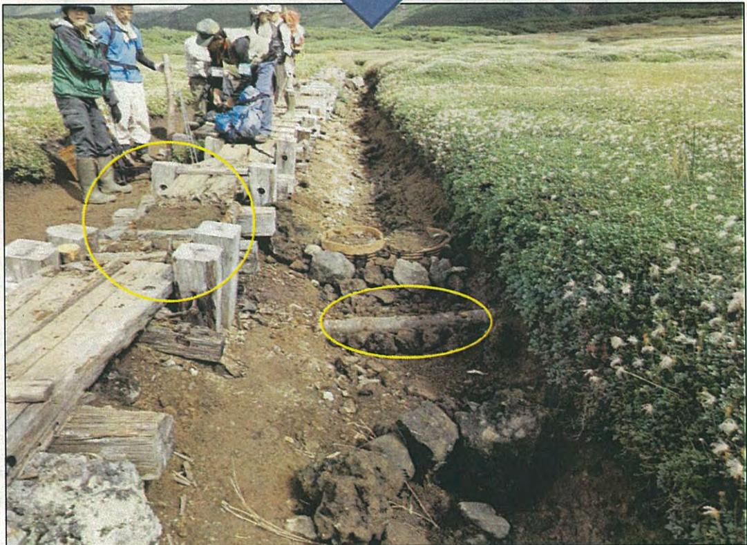
施工後、木道の基部の高さまで土壌が堆積するように施工。
