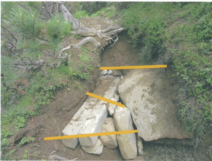
階段工と床止工で処理、角材のステップ上部には石材を詰める（写真角材は暫定処置）
