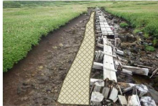
前年に行なったジオウェブでの床固め。礫の流出もなく、脇には土壌が溜まり、チングルマの芽吹きも見られる。表面に礫の追加を行なう予定。
