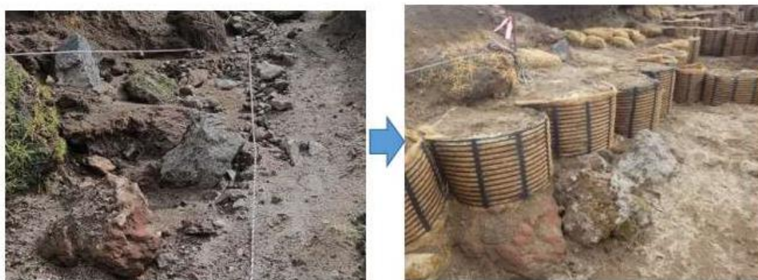
既存の石の上に法面保護テンサーを置き、高さを出している。
