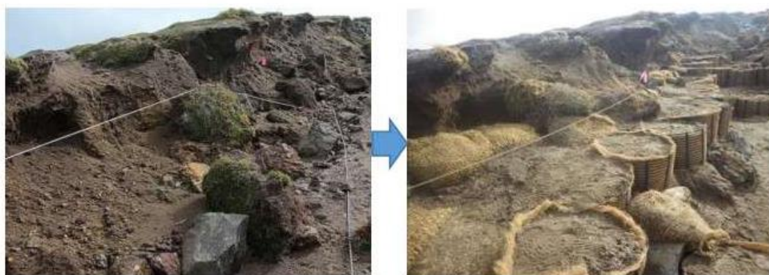
上部①から⑤まで約14m、法面保護テンサーを全て繋げている。
