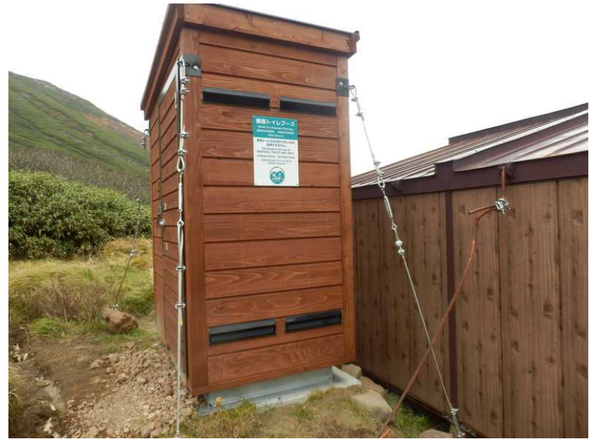
常設型携帯トイレブース (2019年9月完成)
