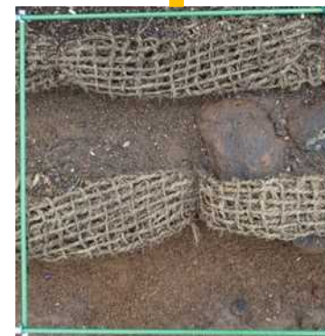
ネット施工区
