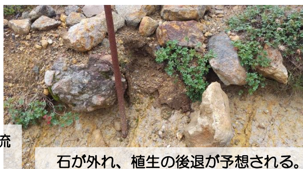
土留め石が脱落し、植生が後退している。
