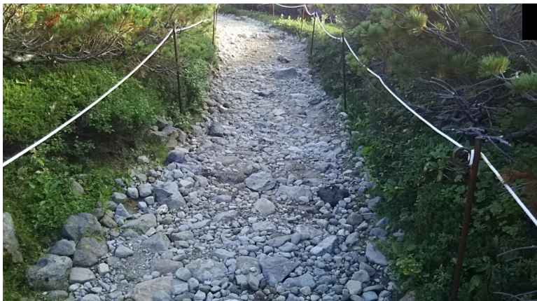
写真⑧ 床止工 施工1年後
