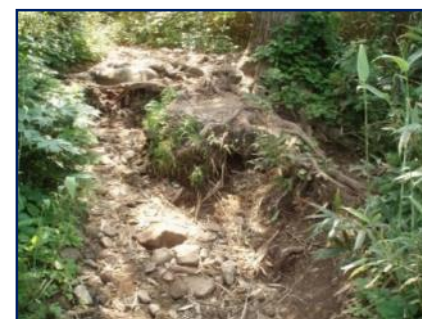
浸食により生じた大きな段差
