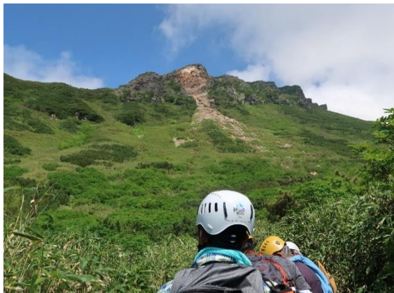
①登山道から見える崩落現場
