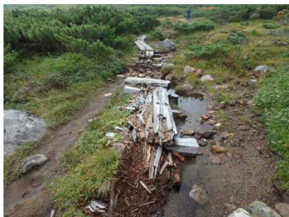
白雲岳避難小屋～五色岳区間（上川町管内）
