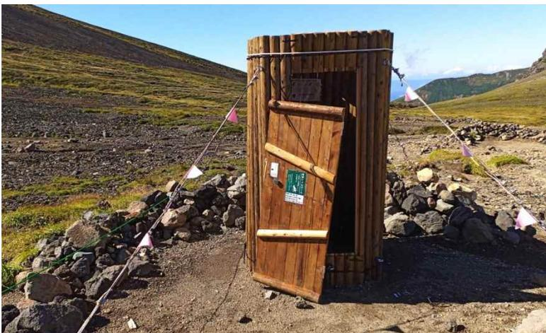
※ 次回設置時、ドアの向きを変える、ラッチを取付ける等の改良が必要。
