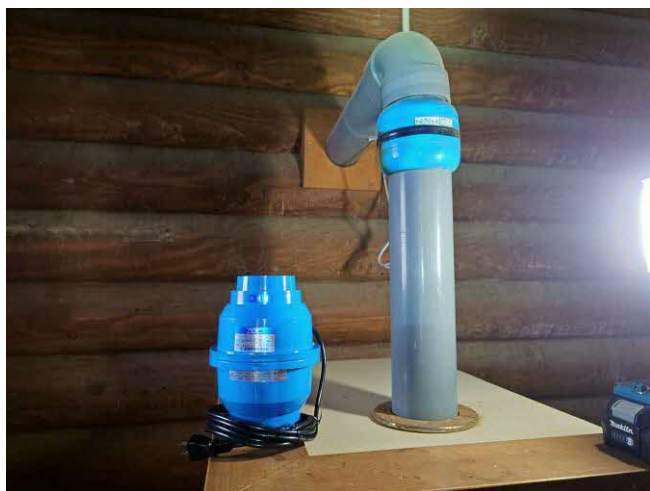
換気ファン2基の交換
