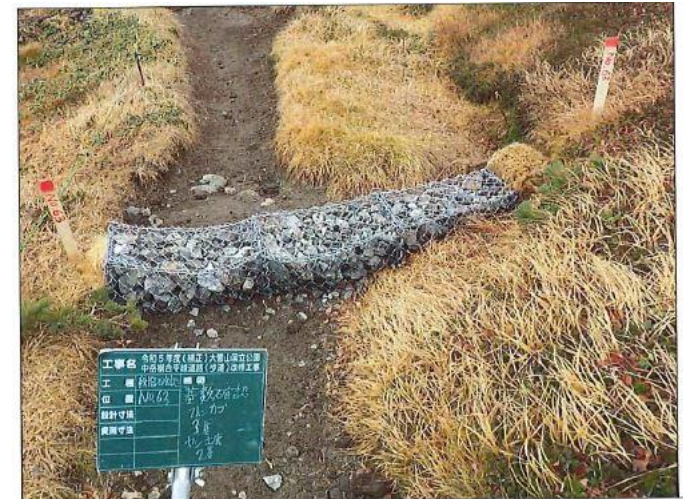
63 カゴ導流工 施工後
