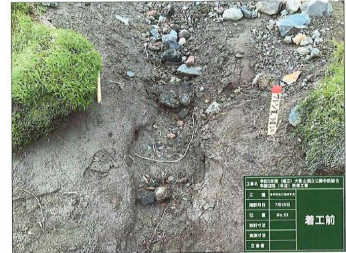
51-2 カゴ床止工 施工前
