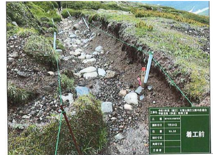
82-2 植生基盤工 施工前
