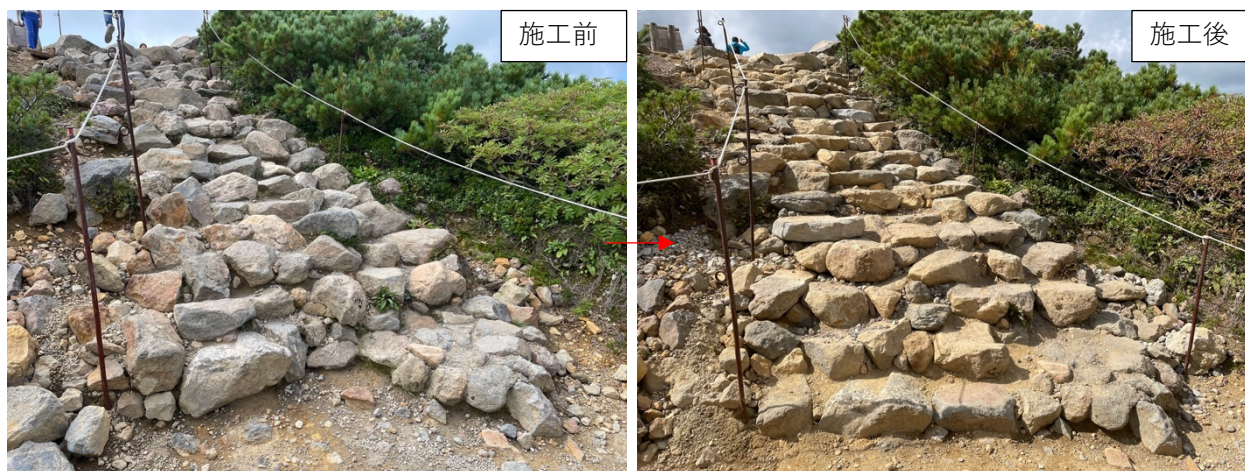
石階段組替え（第1展望台）
