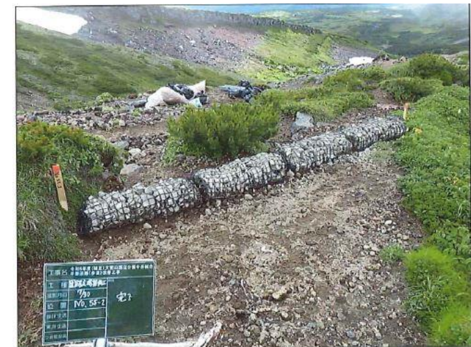
55-2 植生基盤工 施工後
