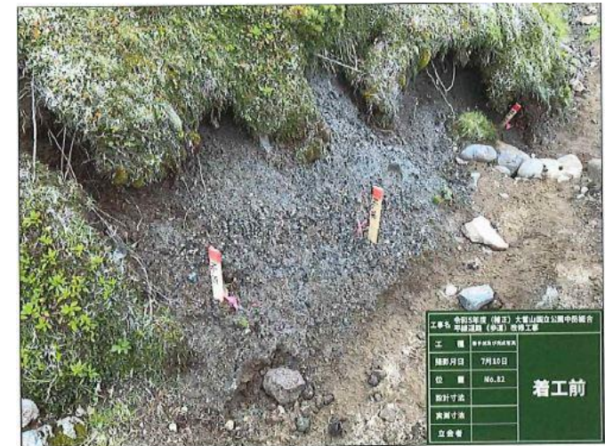
82 植生基盤工 施工前
