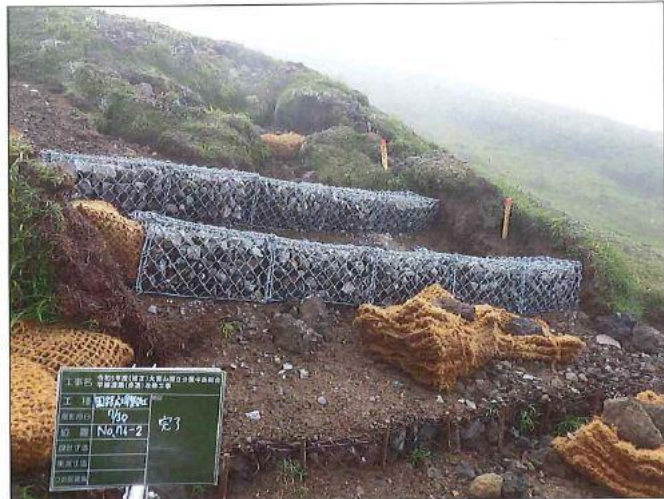
75 カゴ床止工 施工後
