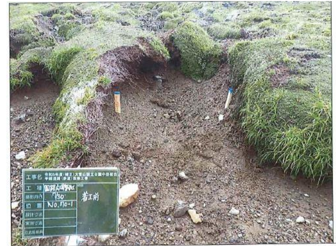
68-3 カゴ床止工 施工前
