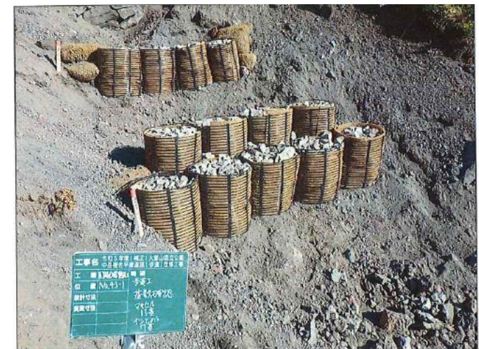
43 マキセル工 施工後
