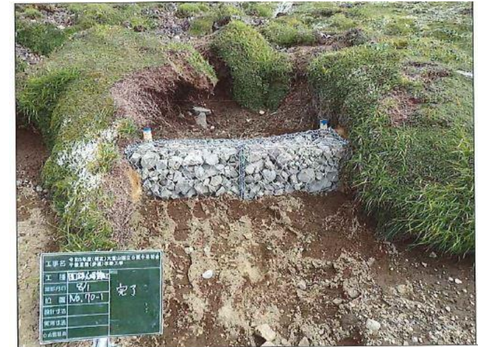
68-3 カゴ床止工 施工後
