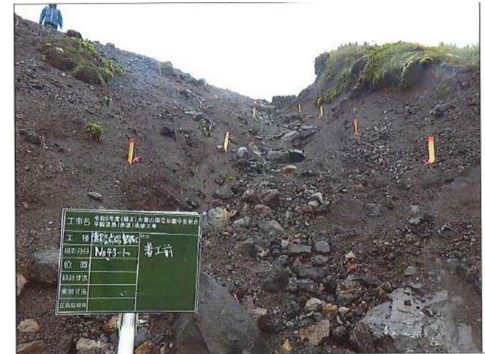
43 マキセル工 施工前
