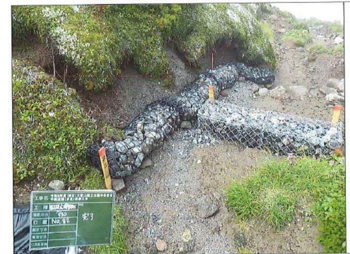
82 植生基盤工 施工後
