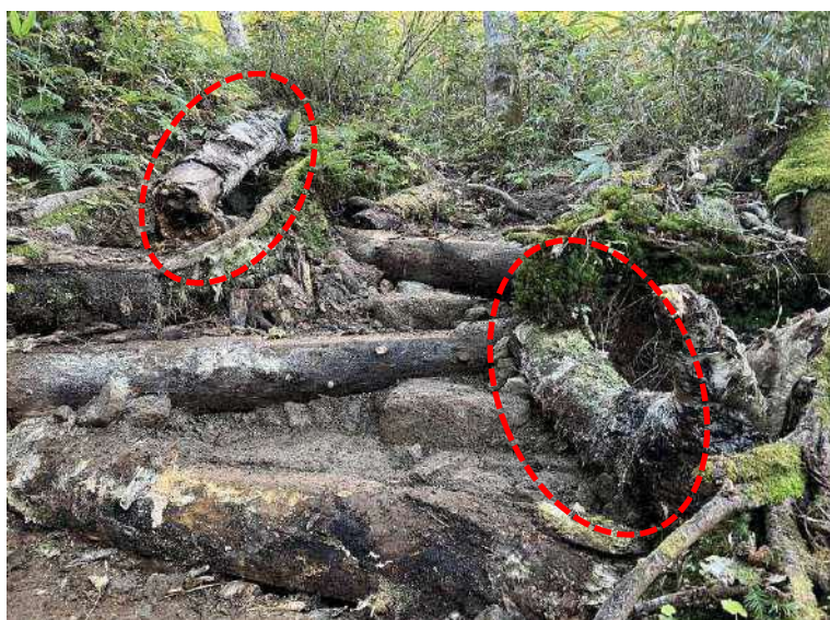
今後法面への踏み込みが無くなるよう、裸地化した部分には倒木や枯れ枝などを配置した。
