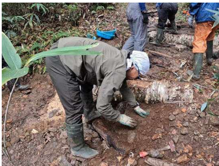
最後に踏み面に砂利を充填。
